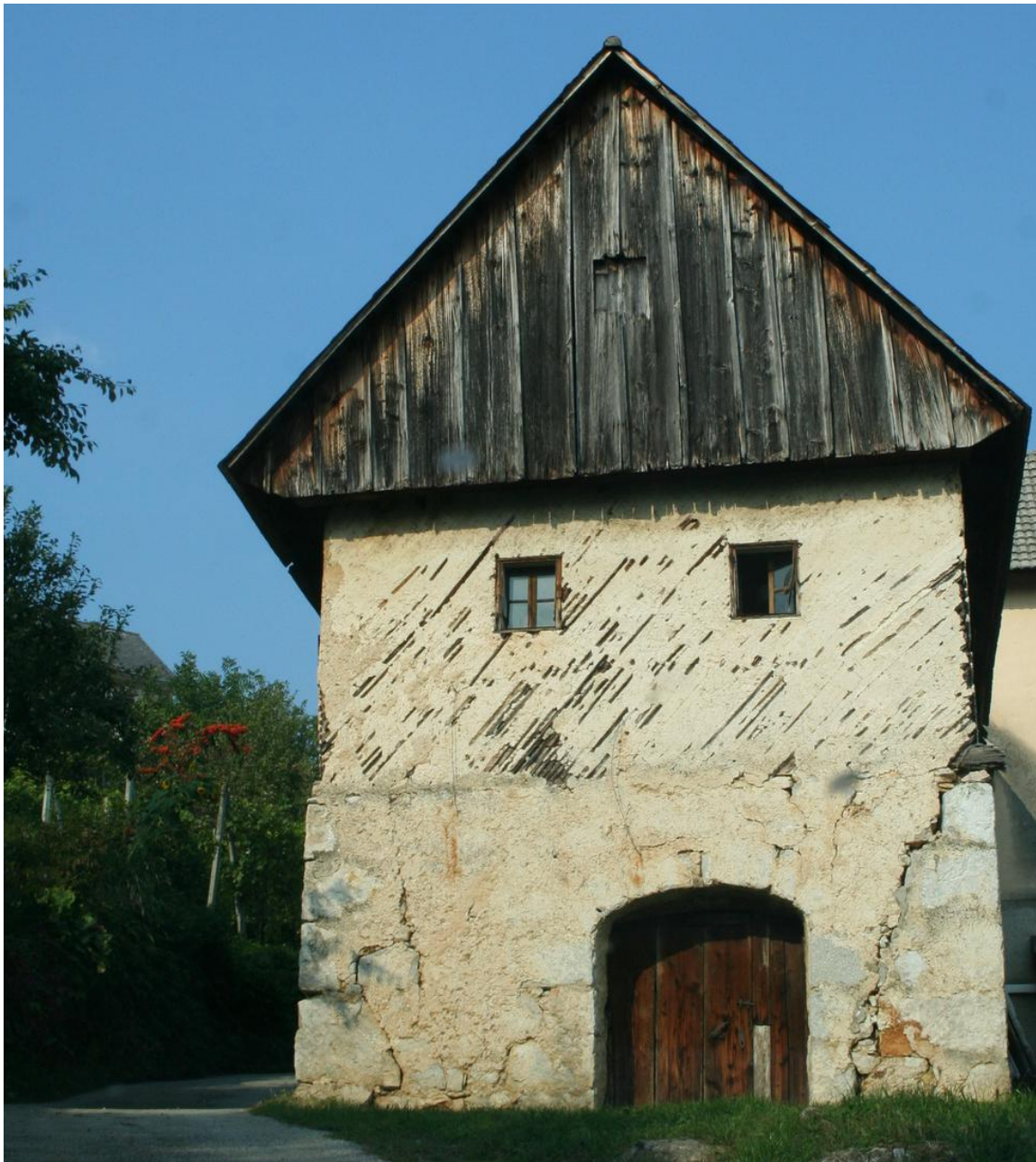
Zidanica v Beli krajni
